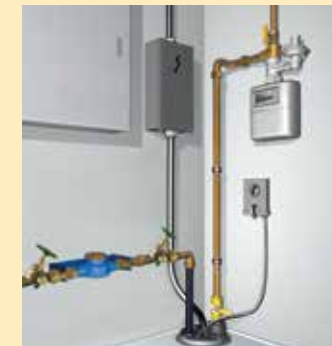
Mehrspartenhauseinführung in runder Bauweise
