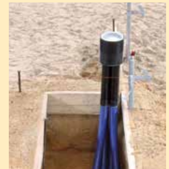
Mehrspartenhauseinführung in runder Bauweise
