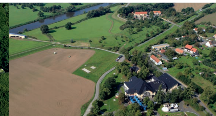
Wasserwerk Canitz mit Rohrbrücke
