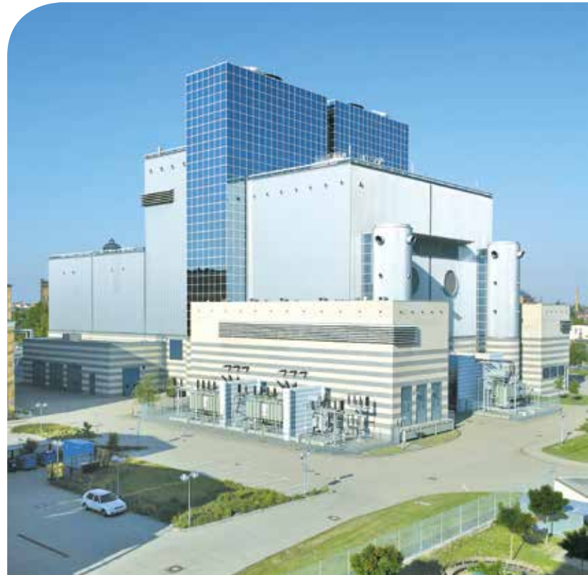
Hoch effiziente Energiegewinnung durch Kraft-Wärme-Kopplung: Die Gas- und Dampfturbinenanlage in der Eutritzscher Straße in Leipzig hat einen besonders günstigen Wirkungsgrad.
